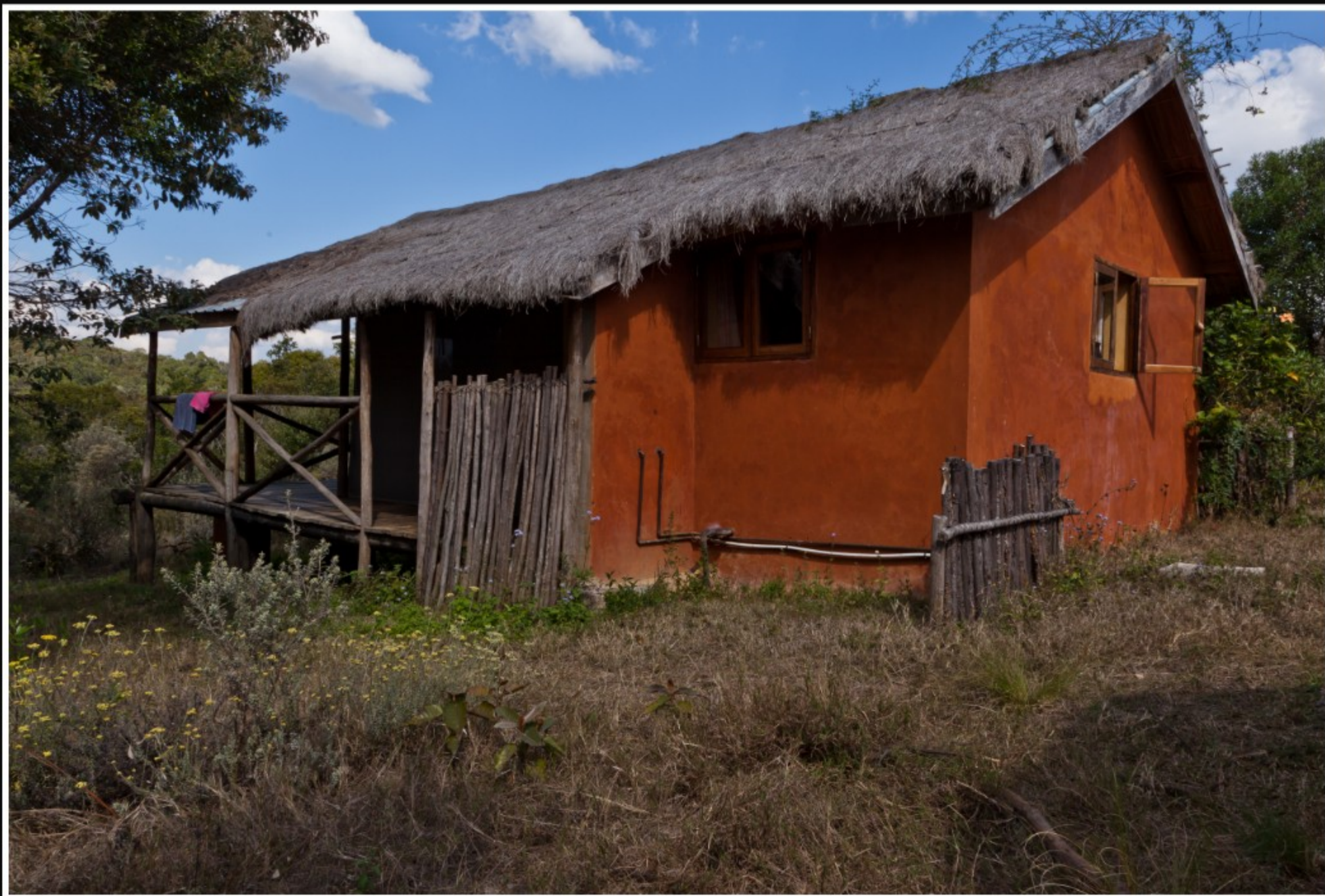
Ostansicht mit Aussendusche ...
